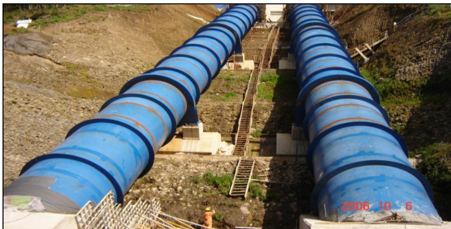
Tuberías en una Central Hidroeléctrica
