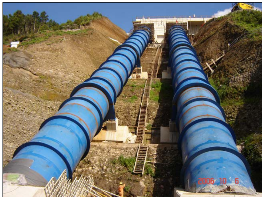
Tuberías en una Central Hidroeléctrica
