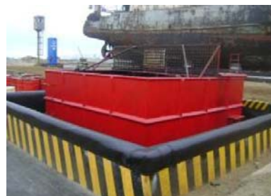
Dique de contención de derrames par el tanque de recepción de mezclas oleosas.
