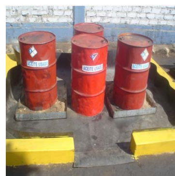
Diques de contención de derrames de productos químicos.
